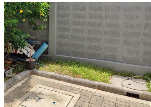
ภาพที่ 10-28 ตะแกรงครอบระบายน้ำป้องกันเศษใบไม้
