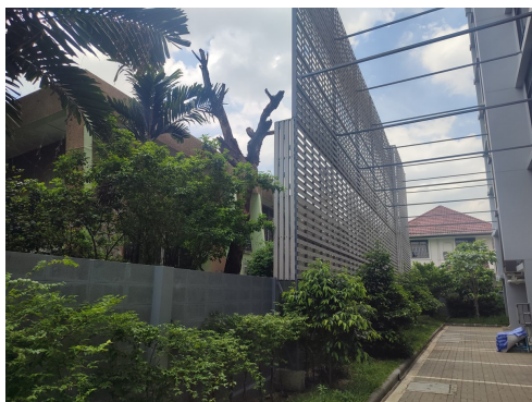
ภาพที่ 10-6 ติดตั้งระแนงเพื่อป้องกันความเป็นส่วนตัวของบ้านเลขที่ 940 และป้องกันลมร้อนจากเครื่องปรับอากาศ
