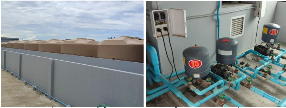
ภาพที่ 10-23 ถังสำรองน้ำชั้นดาดฟ้า และระบบท่อจ่ายน้ำประปาอยู่ในสภาพดีไม่รั่วซึม
