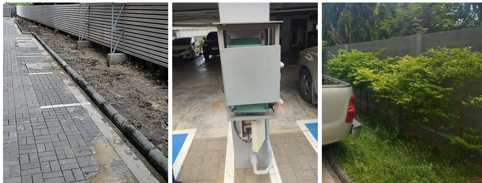
ภาพที่ 10-8 บริเวณบ่อบำบัดน้ำเสีย บั้มเติมอากาศปิดด้วยโฟมกันเสียงดังรบกวนและบ่อดินกักจัดละอองลอยน้ำเสียและก๊าซมีเทน
