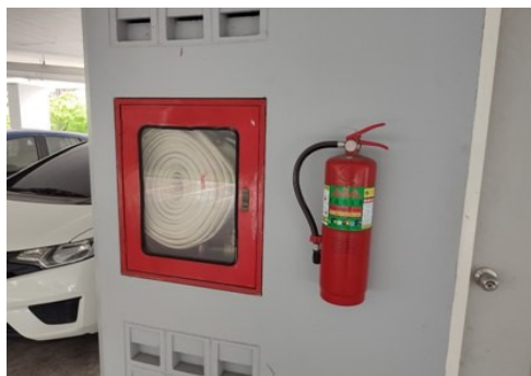
ภาพที่ 10-21 ถังเคมีดับเพลิงและตู้เก็บสายฉีดน้ำดับเพลิง
